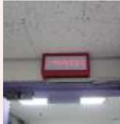
출입문 상부 방출표시등 선로 보수
