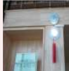
시각경보기 선로 보수
